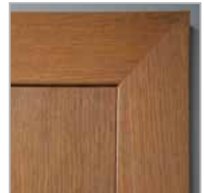
łączenie opasek pod kątem 45°
